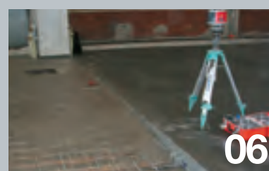
06 Il giorno seguente si procede alla realizzazione della porzione di pavimentazione adiacente.
