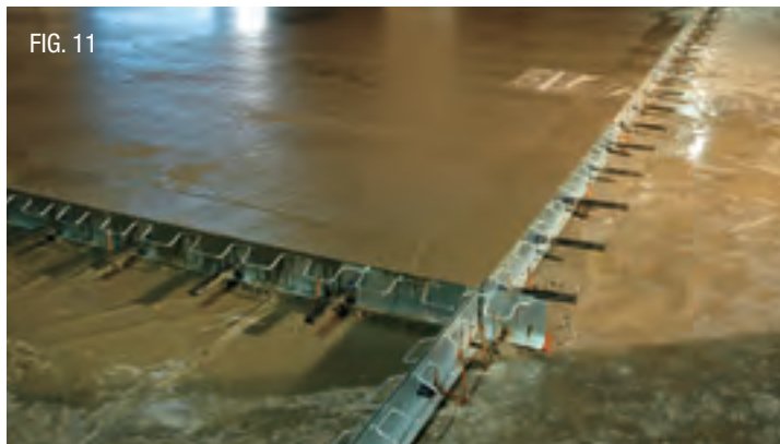
FIG. 11 Particolare di “ripresa di getto” realizzata mediante l’utilizzo dei Giunti di costruzione Ideal Joint System®.
