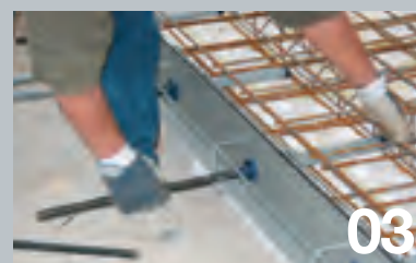
03 I manicotti ovoidali vengono inseriti nel raccordo in PVC.
