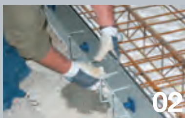
02 I moduli da 3 m lineari vengono assemblati con viti in PVC.
