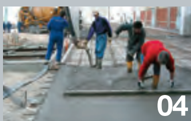
04 Getto del calcestruzzo come di consueto e staggiatura.
