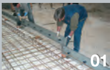
01 Posizionamento e messa in quota.
