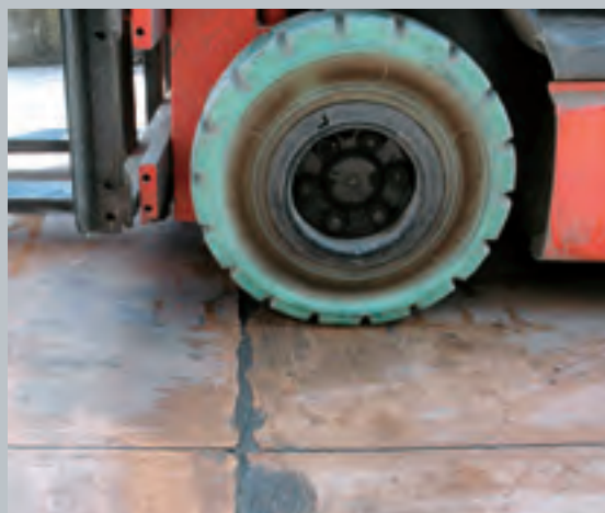
Esempio di giunti di costruzione danneggiati dopo pochi mesi di vita
