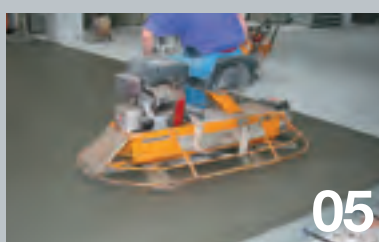
05 Dopo la stesura dell'indurente premiscelato si procede con le fasi di finitura.
